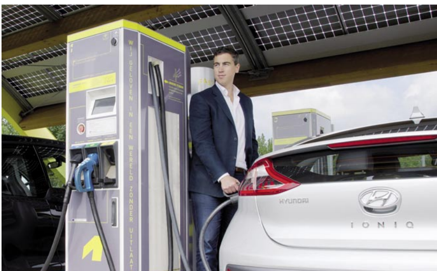
Ladesäulen sind für die Mobilitätswende ein zentraler Baustein, aber leider weist die Infrastruktur in Deutschland noch große Mängel auf. Foto: Fastned
